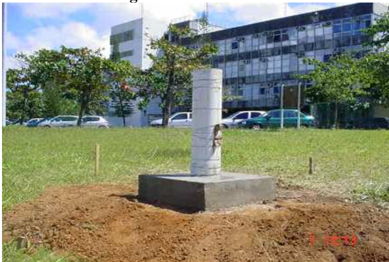
Pilar concretado aguardando a cura
