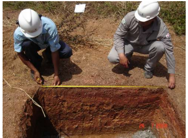
Abertura do buraco conforme dimensões especificadas
